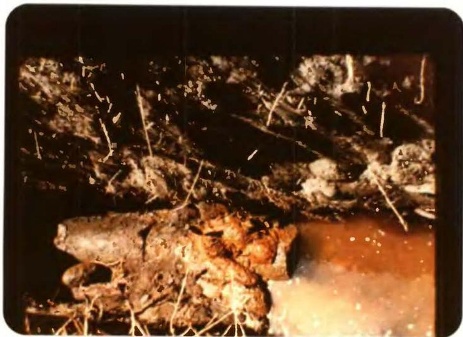
Foto N° 3. Aspecto de un dren descubierto. Sobre el tubo se muestra materia que obtura la línea.
