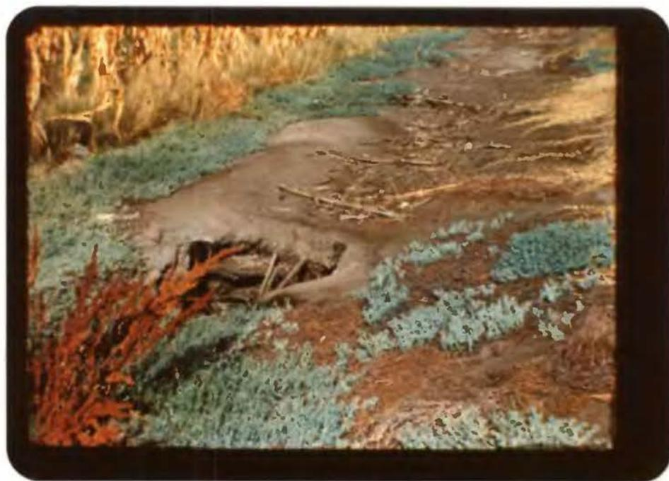
Foto N° 7. Terreno hundido sobre una línea de drenaje.
