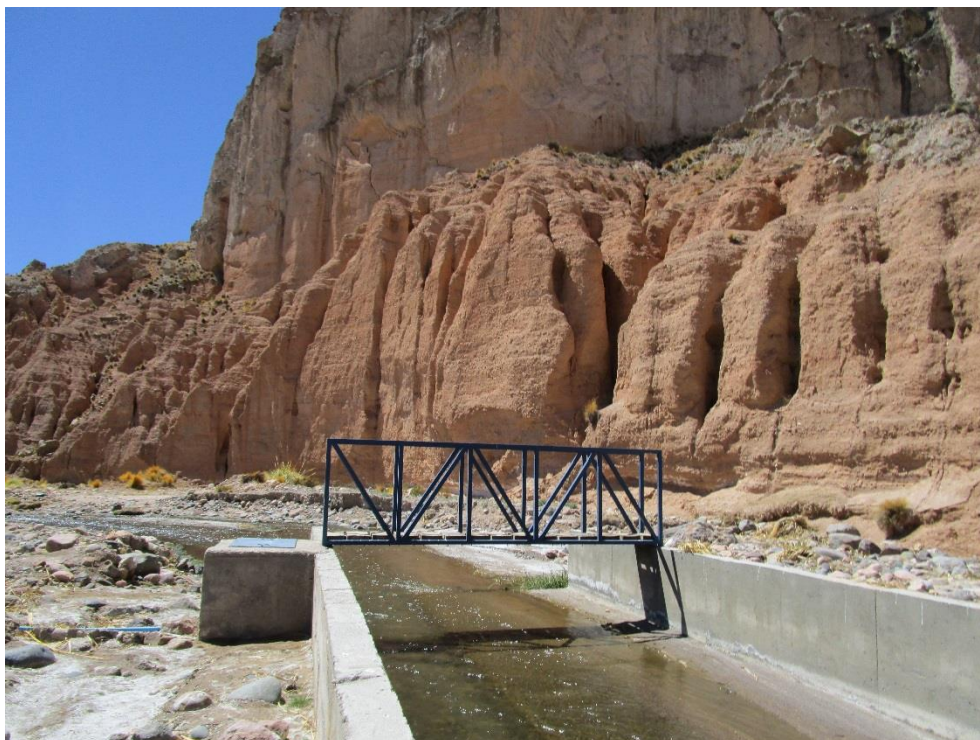
Figura 7.9 Estación Río Colpitas en Alcérreca. Fuente: elaboración propia.
