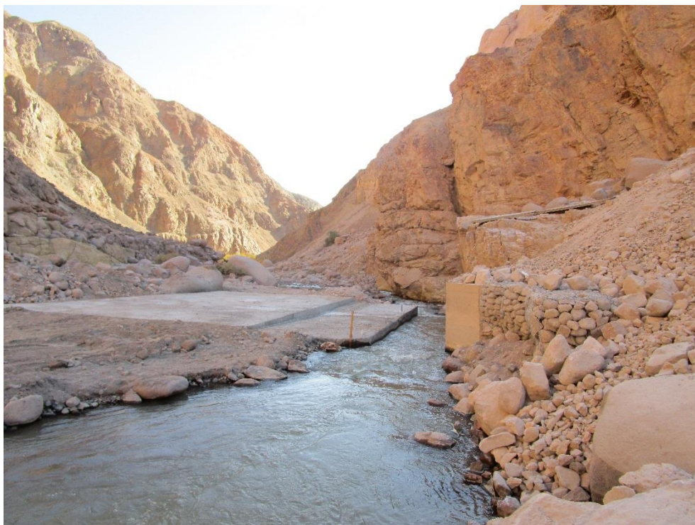
Figura 7.11 Estación Río Camarones en Chilpe. Fuente: elaboración propia.
